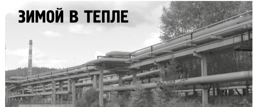
трубопроводов системы отопления и питьевой воды на наполнительное отделение кислородной станции.
